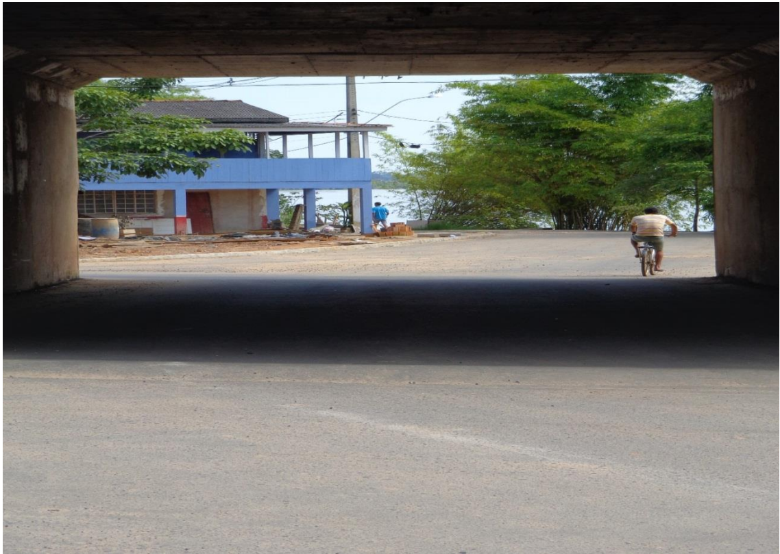
FOTO 7 - Rua sob a ponte
