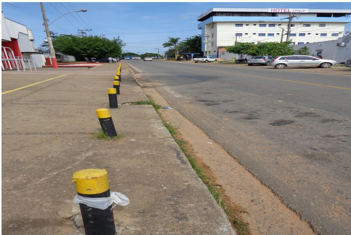
FOTO 8 - Estacas na calçada
